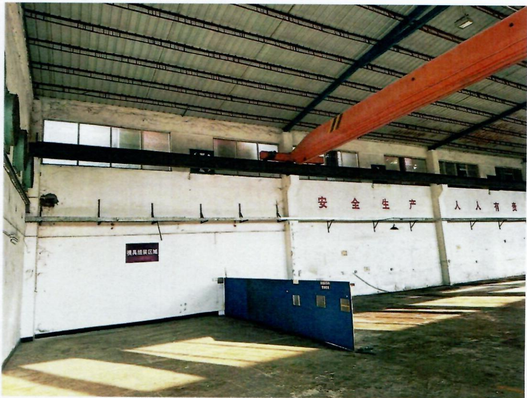
图四 b 厂房现状
